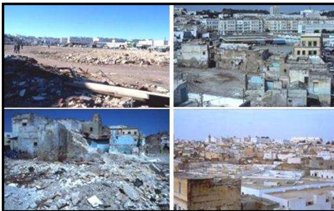
Fig.21 : le quartier HAFSSIA avant sa réhabilitation Source : association de sauvegarde de la médina de Tunis
