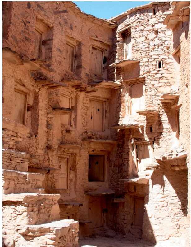
Fig.10 : Agadir marocain réhabilité mais sous-exploité (Agadir Tasguent)
